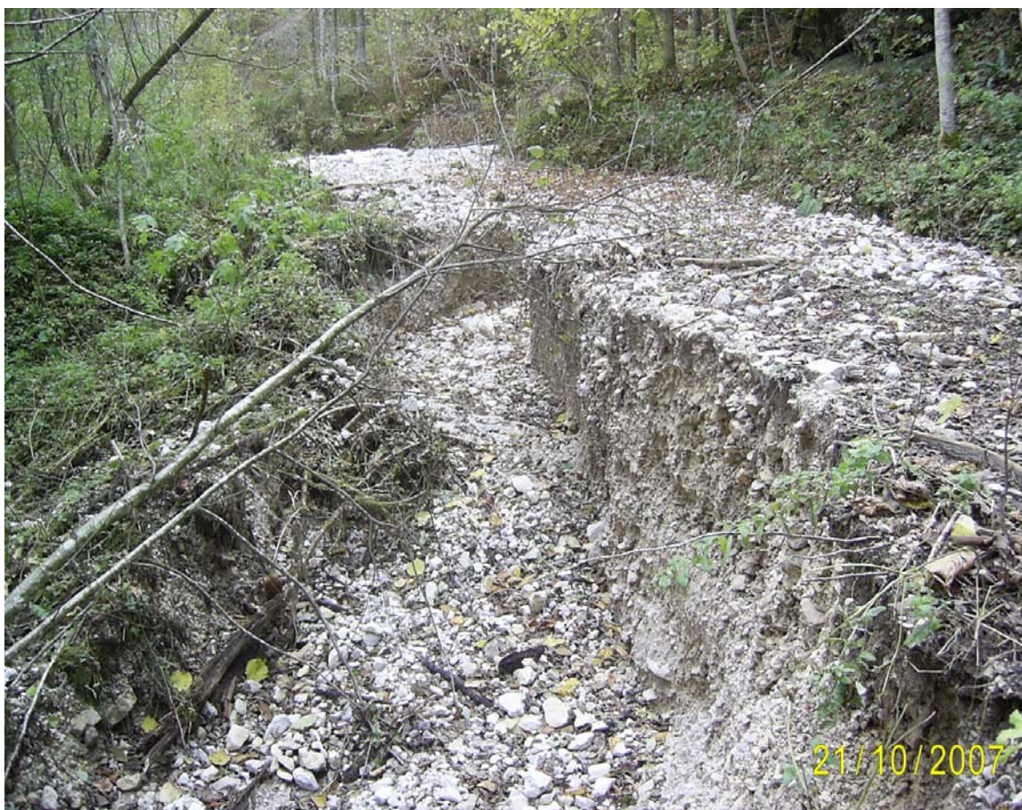
Slika 20: Porušena nasipna brežina
