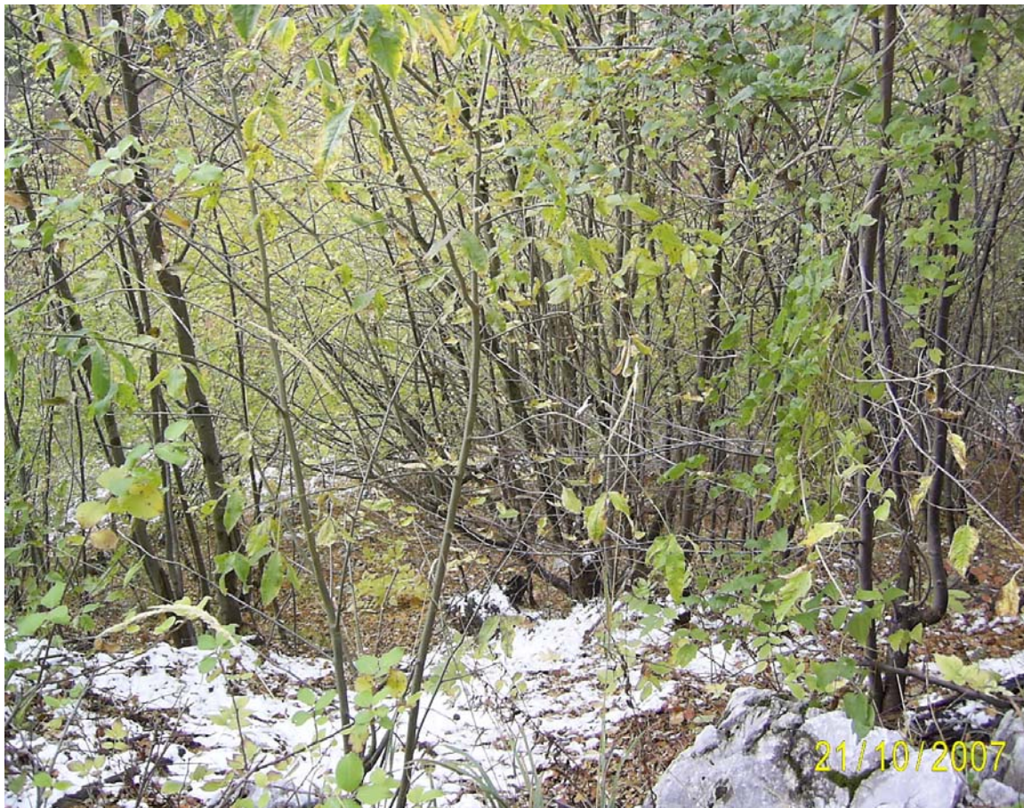
Slika 18: Dobro porasla nasipna brežina.
