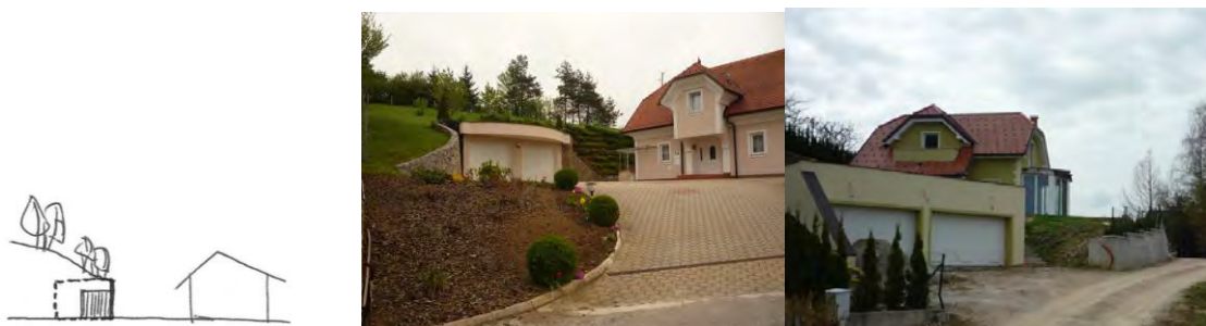
Slika 77 Garaža, vkopana v teren ob hiši – zgornja površina je zasajena in zatravljena
