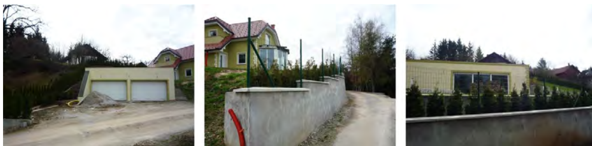
Slika 134 Garaža, vkopana v teren, velika za dva avtomobila (levo), betonski oporni zid pri vstopu na parcelo ter pomožnih objekt ob vikendu (sredina in desno).
