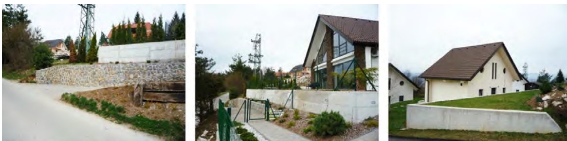
Slika 125 Visoki kamniti in betonski oporni zidovi za reševanje višinskih razlik okoli objektov.
