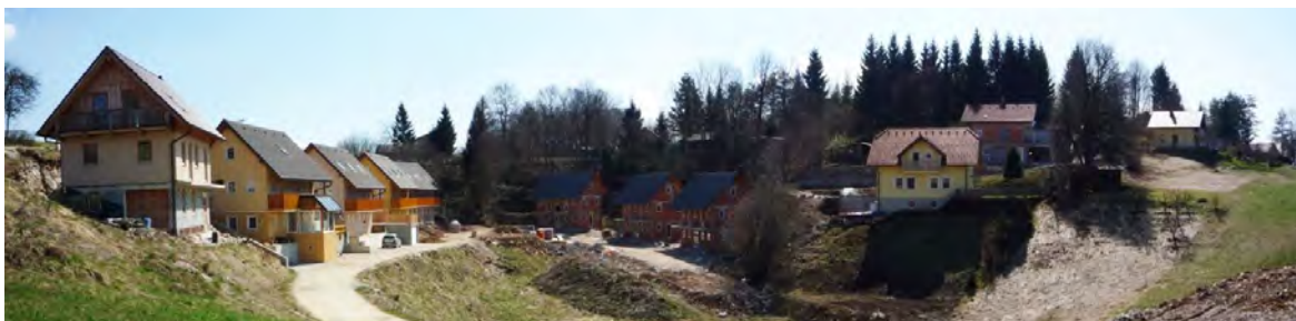
Slika 119 Skupina novozgrajenih počitniških hišic v Škrjanki, zgrajenih na vrtačastem terenu, vkopanih v teren.
