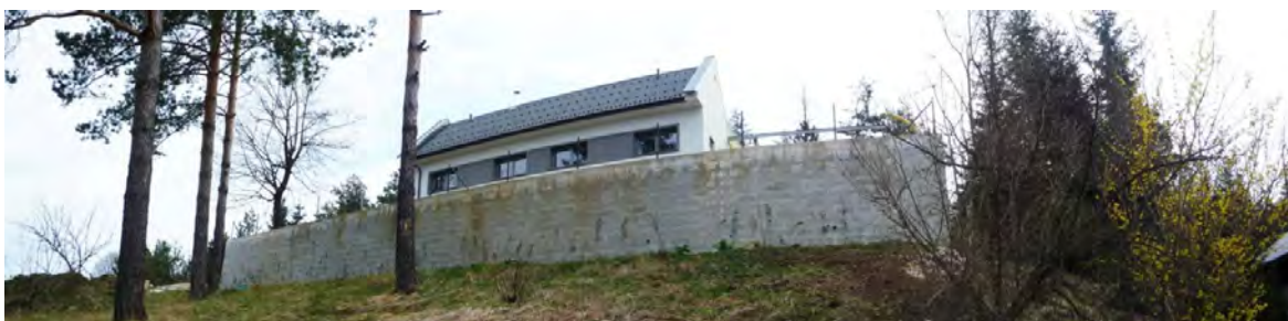
Slika 143 Visok betonski oporni zid za pridobitev površin za bivalni vrt. Posek drevnine.
