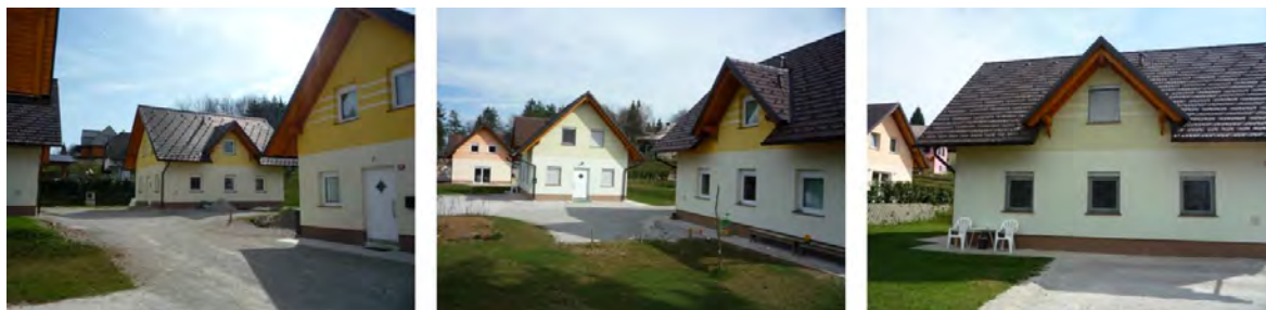
Slika 123 Prostor med vikendi je peščen. Površine zelenic so manjše. Ni zastiranja pogledov iz objekta v objekt, na primer z zasaditvijo drevnine.
