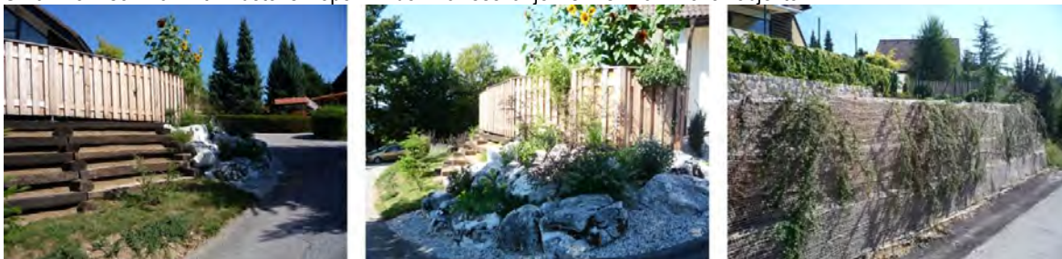
Slika 126 Različni načini premagovanja višinskih razlik. Polaganje lesenih tramov, zasaditev plazečega rastlinja in postavitev lesene ograje (levo), polaganje kamnov in zasaditev cvetočega rastlinja (sredina in desno), kamnite kašte s prekrivnim rastlinjem.
