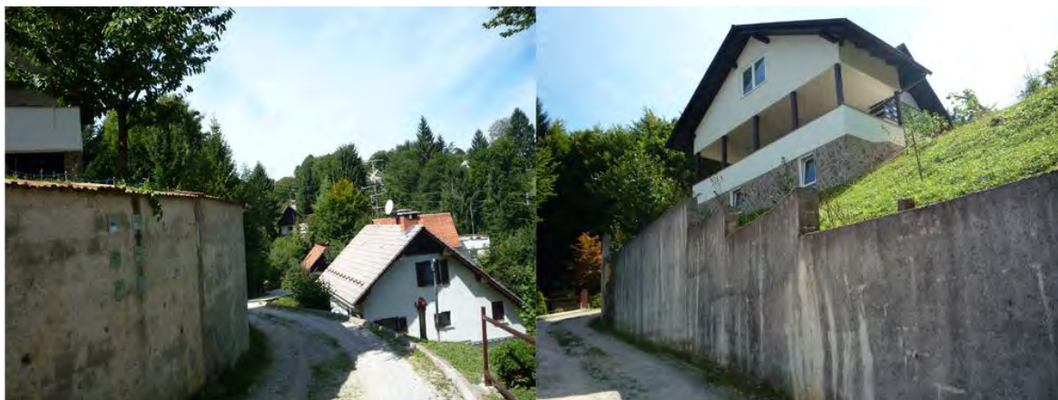
Slika 157 Betoniranje visokih opornih zidov in položitev strešne kritine na vrh betonirane brežine
