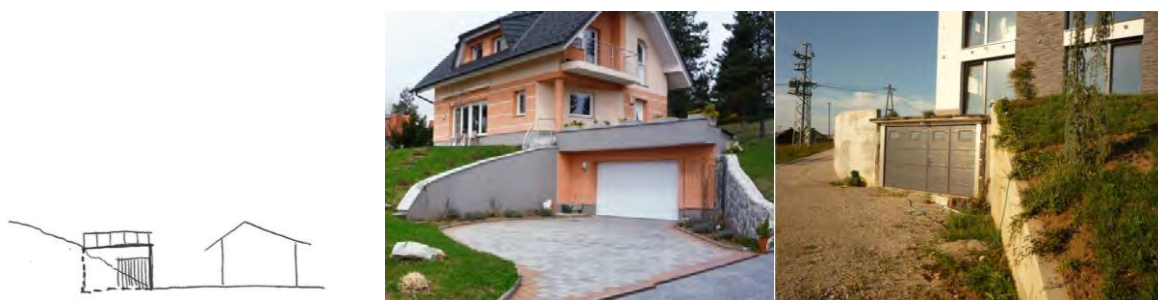
Slika 78 Garaža, vkopana v teren ob hiši – zgornja površina kot terasa
