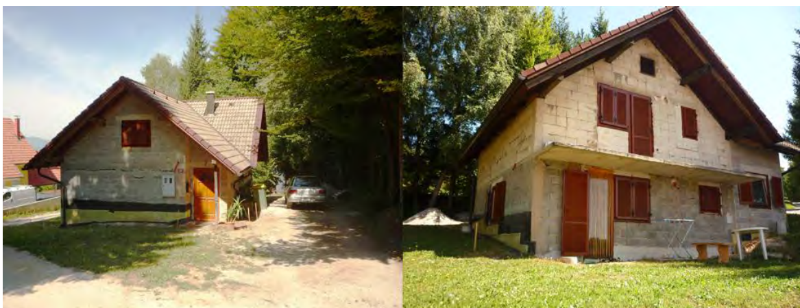
Slika 145 Obnova starejše počitniške hišice in dvig strehe na položnejšem terenu
