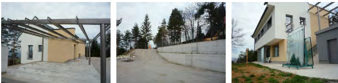
Slika 142 Kovinski nadstrešek za avto (levo), betonski oporni zid (sredina in desno), pomožni objekt ob vikendu in travna površina na vrtu.
