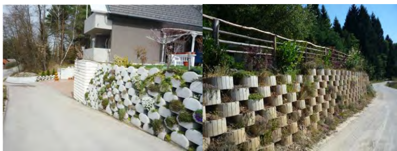
Slika 100 Reševanje višinskih razlik – brežina (polaganje škarpnikov z zasaditvijo cvetočega rastlinja)
