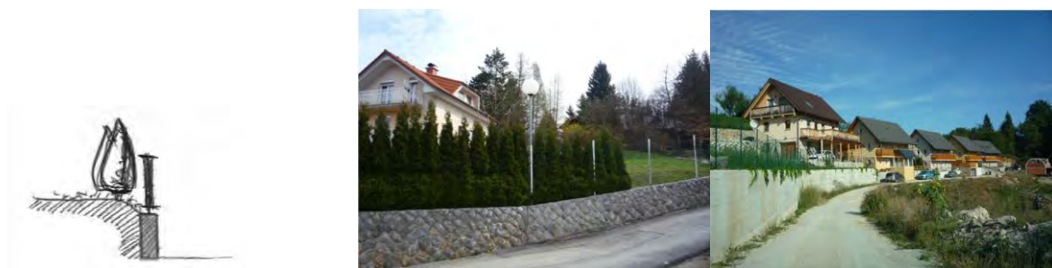
Slika 105 Reševanje višinskih razlik –kamnit ali betonski oporni zid + ograja + zasaditev (grmovnic ali plazečega rastlinja, ki sčasoma prekrijejo oporne zidove)
