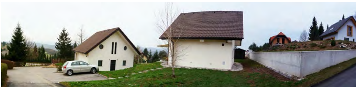
Slika 128 Asfaltiran dostop in parkirna površina ob objektu. Dostopanje s spodnje strani. Parcela ni ograjena.
