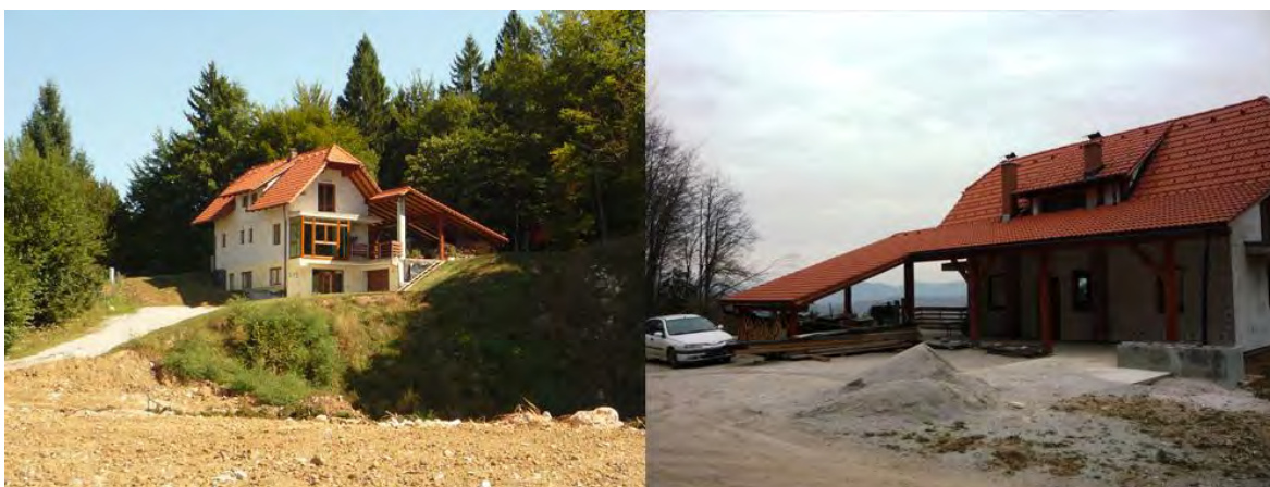
Slika 146 Obnova vikenda in dozidava objekta z vseh strani na nagnjenem terenu (garažni nadstrešek, garaža v hiši, gradnja nadstropja)
