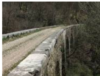
Slika 31: Viadukt trase proge Hrpelje - Kozina-Trst pod Nasircem
