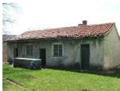
Slika 49: Objekt ob kasarni v Mihelah
