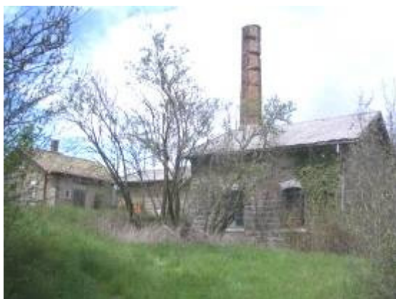
Slika 40: Objekt vodne črpalke in čuvajnice
