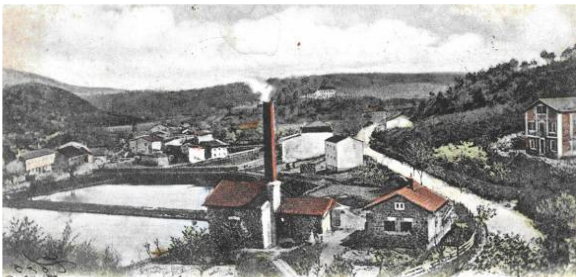
Slika 39: Kompleks vodne črpalke na približno 100 let stari razglednici
