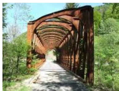
Slika 14: Eden od številnih ohranjenih in obnovljenih mostov na kolesarski poti po trasi proge Jesenice–Rateče
