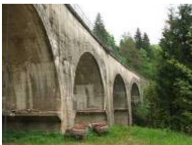
Slika 21: Viadukt Gornji Dolič na trasi proge Velenje–Otiški Vrh
