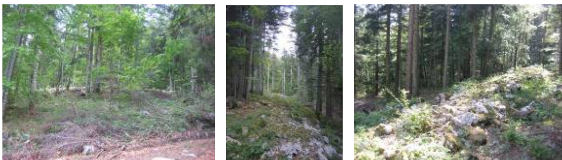
Slika 36: Stanje zapornega zidu nad Prezidom po temeljiti odstranitvi vegetacije
