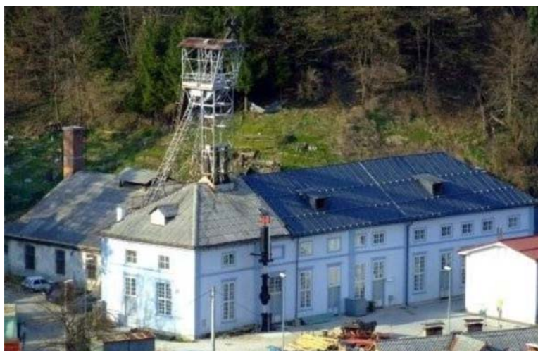
Slika 25: Stavba jaška Frančiške (Jašek Frančiške, 2009)
