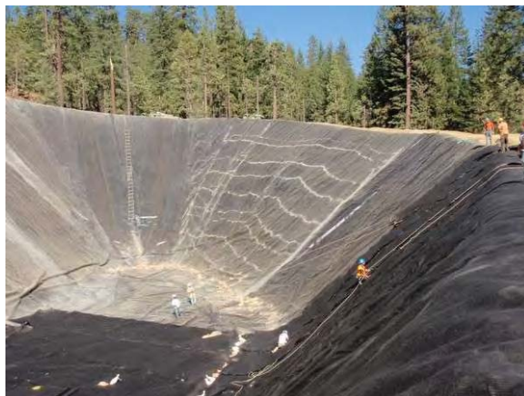
Slika 8: Polaganje prvih plasti čez izkopano jamo (Altoona mine ..., 2009)
