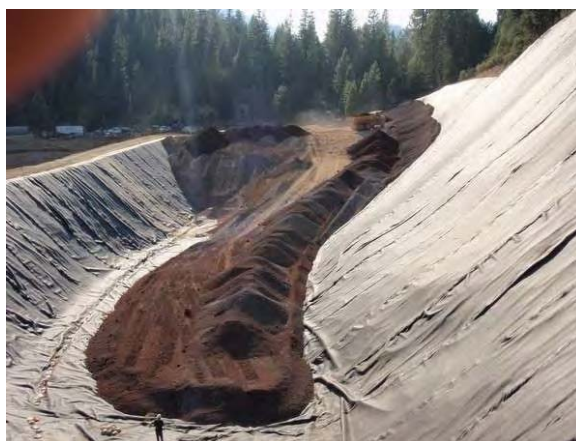
Slika 9: Zasipavanje jame z jalovino (Altoona mine ..., 2009)
