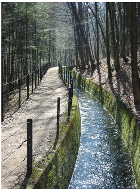
Slika 23: Vodno korito Rake, ki je poganjalo vodno rudniško črpalko Kamšt
