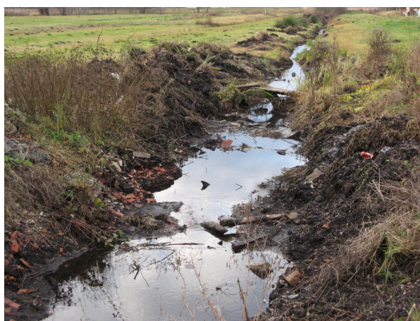
Slika 13: Iztekanje odpadnih voda
