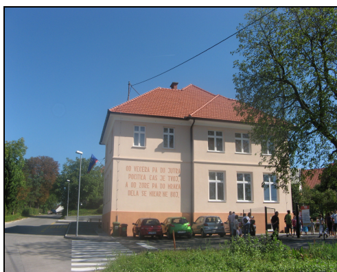
Slika 9: Šola Bevke po zadnji prenovi
