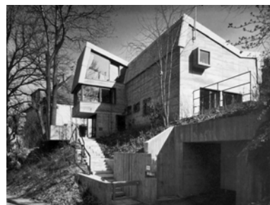
Slika št. 50: Izravnavna terena + dvignjena terasa; zgled Meyer-Bohe (1970)
