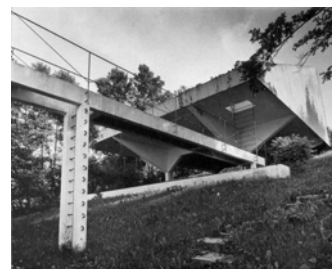
Slika št. 54: Ohranjanje obstoječega terena s terasami na stebrih; zgled Meyer-Bohe (1970)
