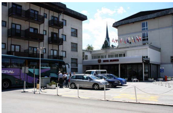
Slika 92: Hotel Jelovica, v ospredju je neprimerno urejeno parkirišče.
