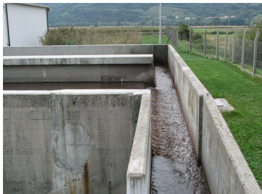
Slika 8: Iztok iz primarnih usedalnikov.
