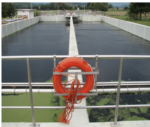
Slika 13: Sekundarni usedalnik in vodna leča v ospredju.
