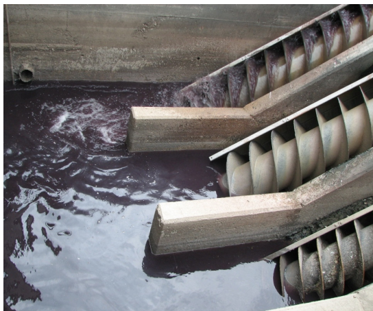
Slika 3: Vhodno črpališče s polžastimi črpalkami. Na sliki deluje zadnja.
