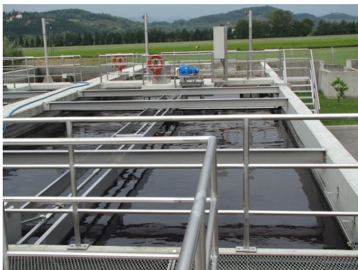
Slika 7: Primarni usedalnik.
