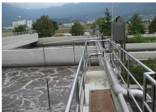
Slika 12: Merilnika koncentracije kisika in suhe snovi v tretji skupini prezračevalnih bazenov.
