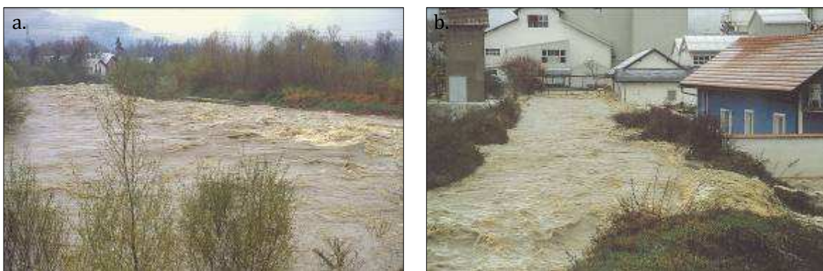
Slika 22a. in b.: Narasla Kamniška Bistrica z mostu pri Ihanu (na levi) in predrti nasip v Vidmu (na desni) ob poplavih 1998 (Komac in sod., 2008: 92)
