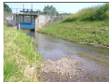
Slika 28: Vhod v razbremenilnik z zapornico, ki se aktivira ob nevarnosti poplave v Ljutomeru.
