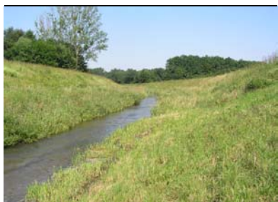
Slika 26: Regulirana struga pred Ljutomerom z visokovodnimi nasipi.
