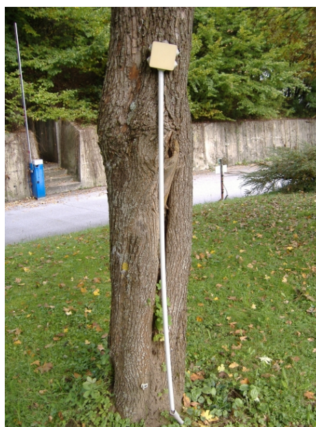
Slika 11: Na drevo pritrjena električna napeljava in izvotlitev debla.
