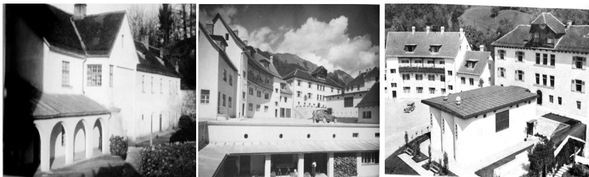
Slika 17. Samostan s pekarno (levo), uprava, negativa, kapela (sredina in desno) leta 1928
