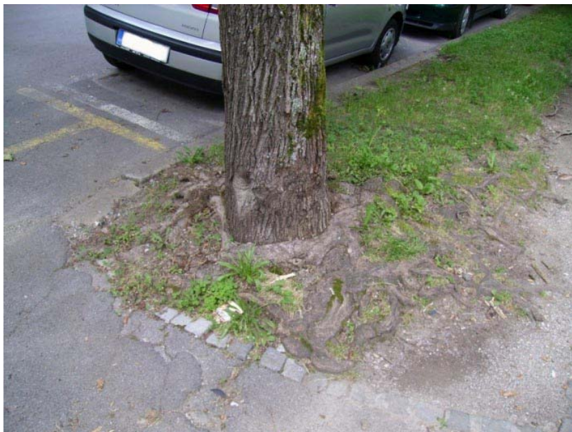
Slika 8: Koreninski sistem drevesa št. 41 v drevoredu Prule – Grudnovo nabrežje je utesnjen, vidne pa so adventivne, obkrožujoče in zelo poškodovane korenine.
