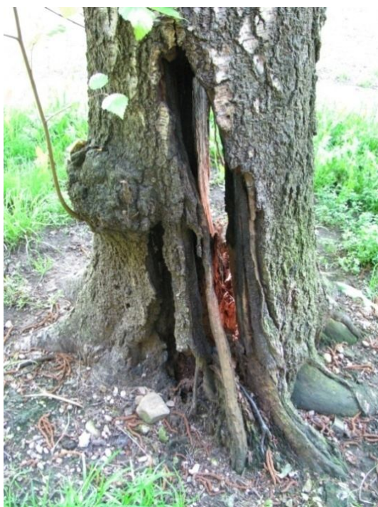
Slika 57 (levo): Močno poškodovan koreničnik pri brezi št. 19
