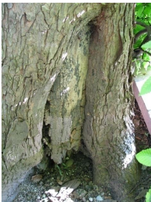
Slika 44 (levo): Poškodba na koreničniku pri javorju št. 10
