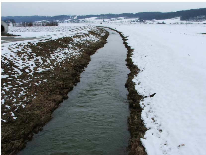
Slika 8: Gole brežine brez drevesne in grmovne vegetacije za mostom v kraju Grabe, pozimi (foto: Stolnik 2006)
