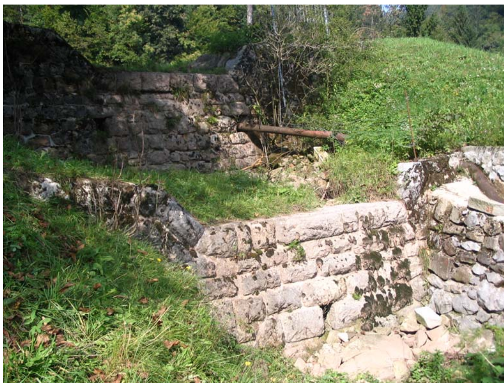
Slika 15 – Pregradi v Valjavčevem potoku, kjer je skozi drenažno odprtino speljana cev vodnega zajetja
