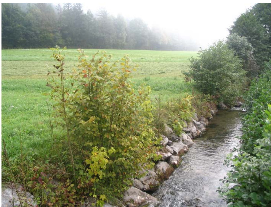
Slika 22 – Zavarovanje brežine s kamnito zložbo v suho
