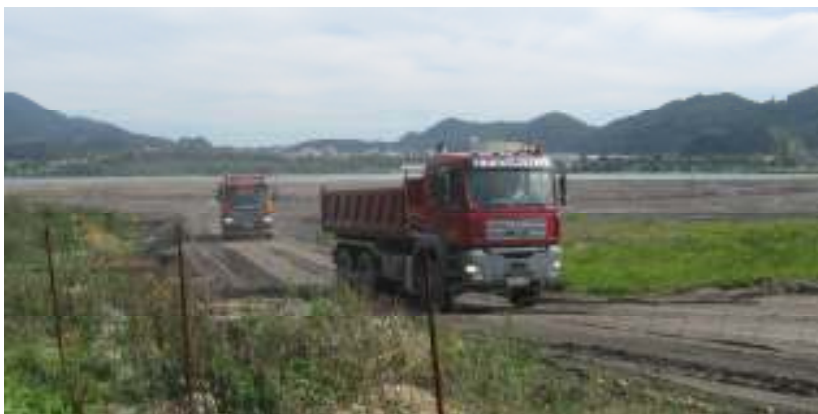
Slika 35: Tovornjaki in drugi gradbeni stroji so na pregradi prisotni vsakodnevno
