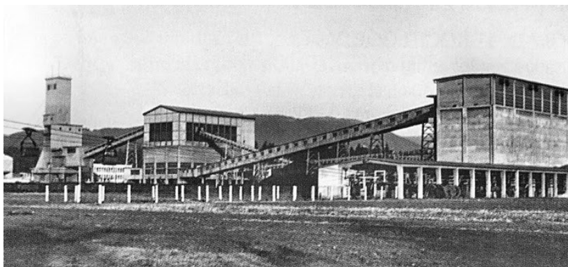
Slika 4: Po drugi svetovni vojni so zgradili novi jašek ali »Novi Šaht«, ki se je začel zaradi kopanja pod njim pogrezati in je danes skoraj v celoti pod površjem (Šterbenk, 1999)
