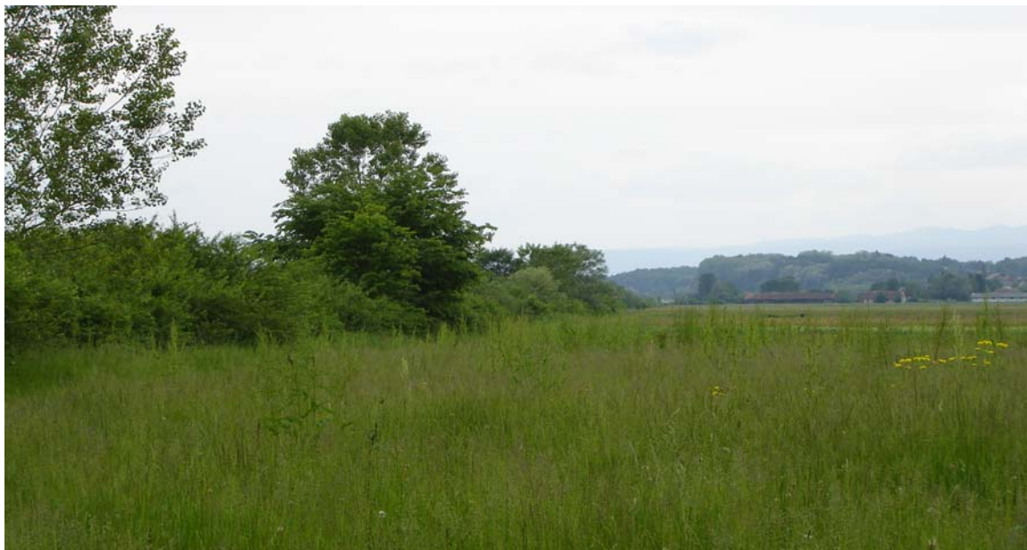
Priloga C1: Zarast na melioracijskem jarku 1 kaže na slabo in nepravilno vzdrževanje le-tega. Prevladujejo drevesne in grmovne vrste.
