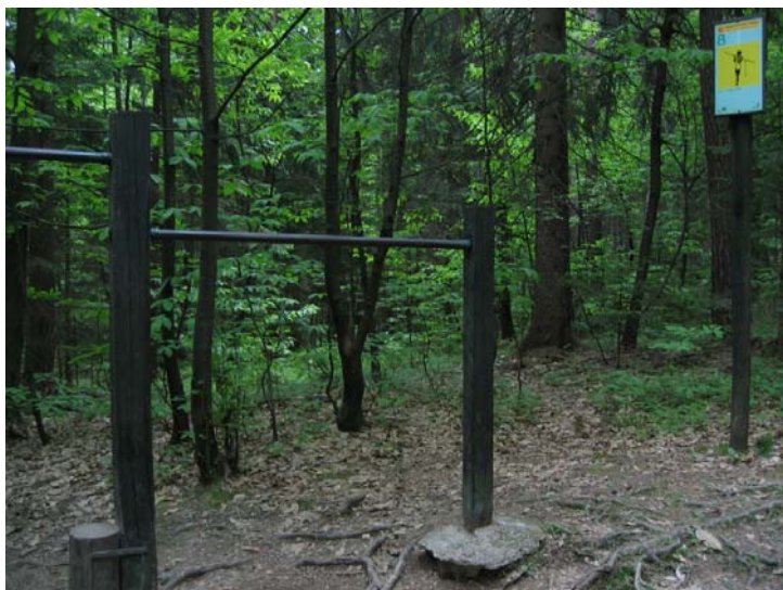
Slika 25: Naprava na trim stezi z erodiranimi temelji (Verlič, 2006)
