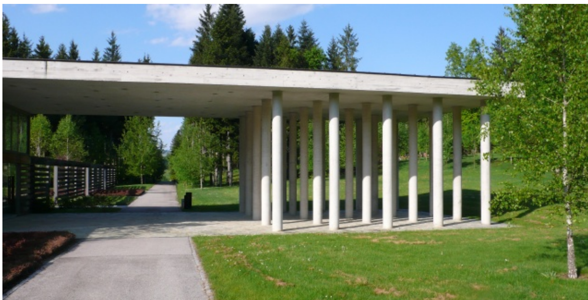
Slika 8: Nadstrešnica poslovilnega objekta na pokopališču v Srebrničah pri Novem mestu (Látszóbeton ..., 2012)
