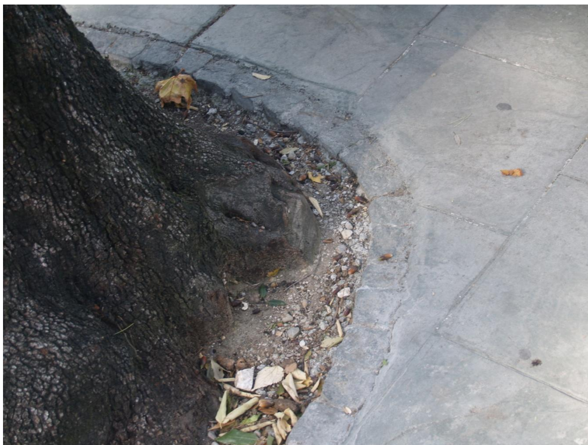
Slika 20: Za lažje betoniranje so črniki kar prirezali korenine
