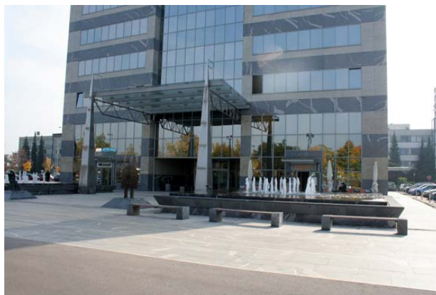
Slika 36: Fotografija ureditve okrog poslovne stolpnice BTC City (21. okt. 2008)
