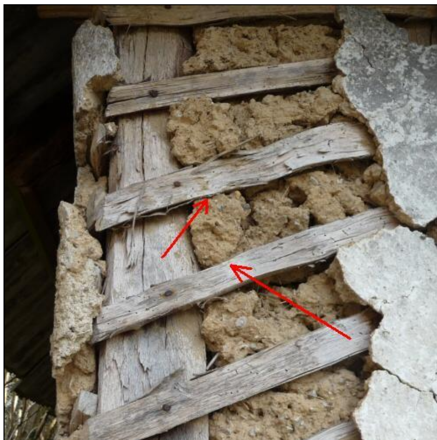
Slika 1: Prostori med lesenimi elementi so zapolnjeni z glino (foto: F. Pohleven)
