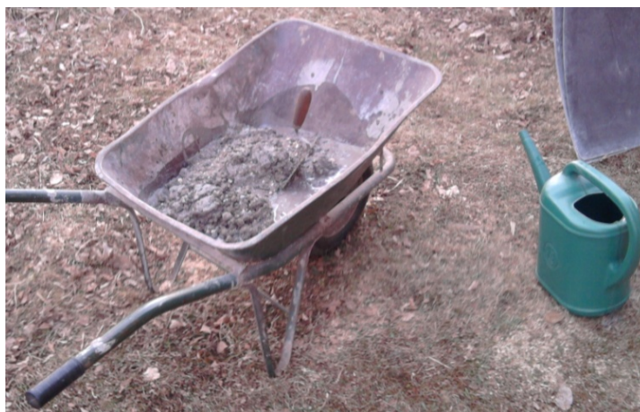
Slika 6: Priprava in mešanje sestavin za beton.
