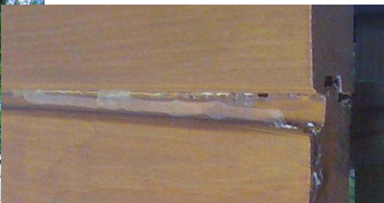
Slika 26: odstopanje filmav primeru B 1.4 ter odprtje spoja utor pero
