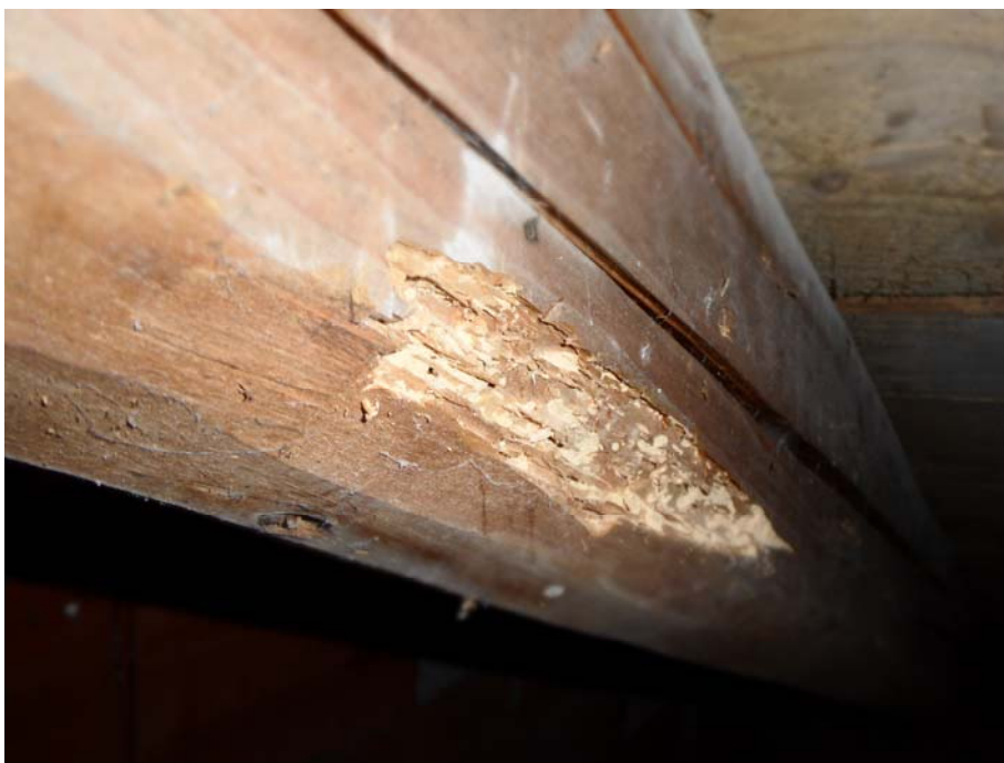
Slika 12: Napad hišnega kozlička na ostrešni tram (foto: B. Mikuš)
