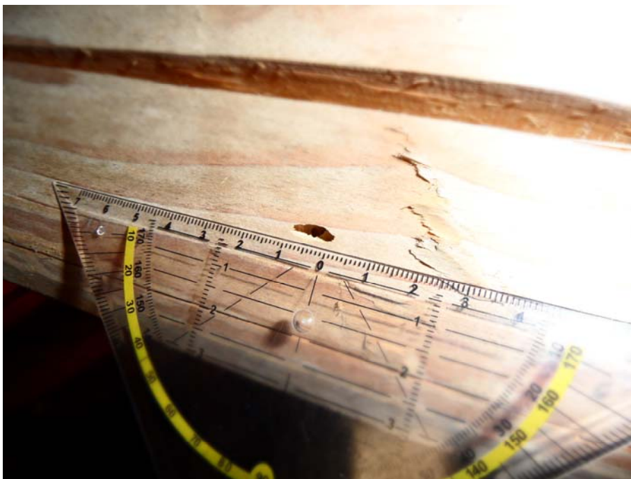
Slika 13: Izletne odprtine na ostrešnem tramu (foto: B. Mikuš)
