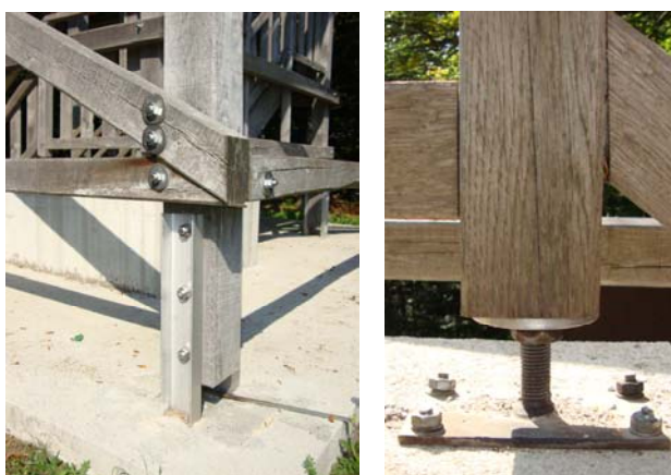
Slika 75: Način za podaljšanje trajnosti lesenih stebrov – odklik lesa od tal (foto: Andraž Nagode)
