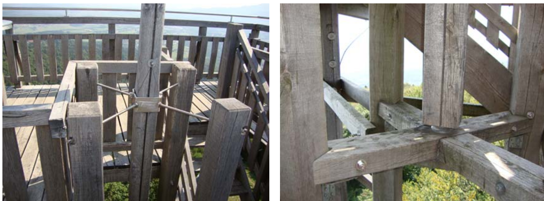
Slika 78: Osrednji steber, ki je namenjen obešanju zastave, dodatno pritrjen z jeklenim profilom. Steber stoji na nosilnih elementih, ki sta povezana z polno preklopno vezjo (foto: Andraž Nagode)
