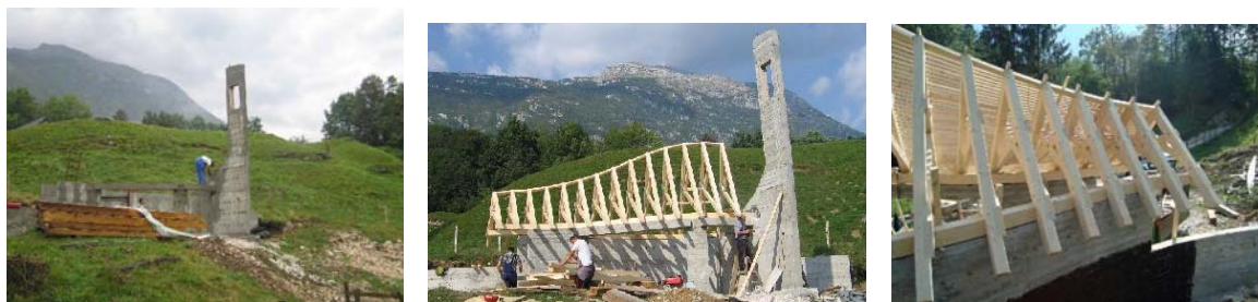
Slika 71: Primer izdelave sodobne strešne konstrukcije (kapelica v Bovcu) l. 2009 (Kregar, 2009)
