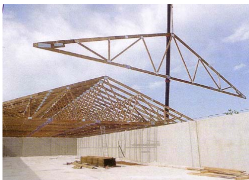
Slika 41: Palična konstrukcija, primerna za industrijsko halo (Saje, 1997)
