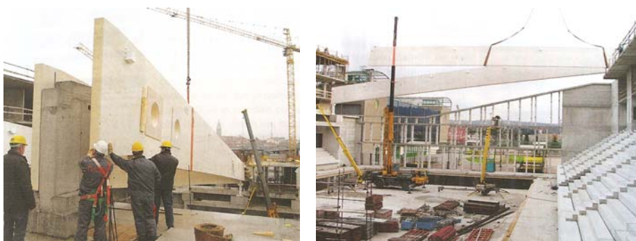
Slika 20: Montaža 44-metrskih nosilcev za streho bazena v Kopru (Montaža, 2011)
