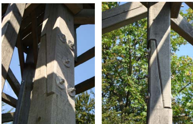
Slika 81: Natančna izvedba lesne zveze (ravno preklapljanje s poševnim stikom), ki je pritrjena z jeklenimi vijaki (foto: Andraž Nagode)
