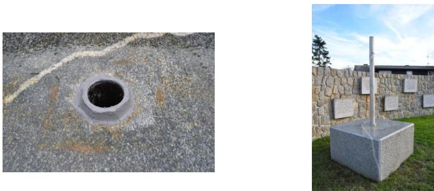
Slika 67: Protikorozjsko zaščiten ostanek stare cevi v podstavku, (levo), namestitev nove cevi (desno)
