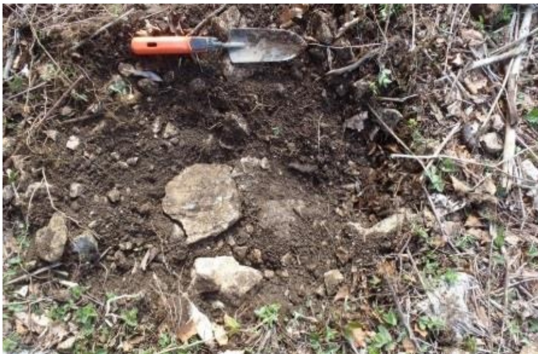
Slika 83: Skeletno vozišče vlake lahko onemogoči meritve dinamičnega deformacijskega modula
