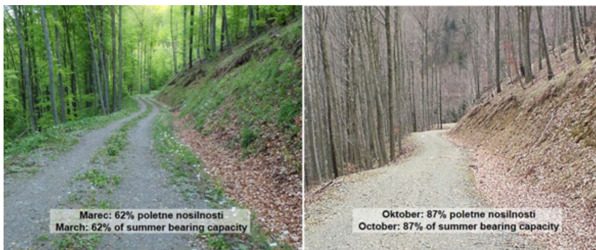
Slika 82: Sezonska nihanja nosilnosti vozišča stranske gozdne ceste na mešani podlagi
