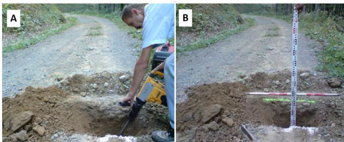
Slika 32: Izvedba vzorčnega izkopa (A) in popisa notranje morfologije voziščne konstrukcije (B)
