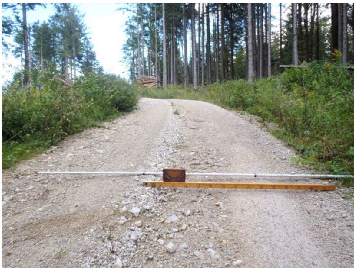
Slika 30: Oprema za meritve dimenzij cestišča ter prečnega naklona in prečne ravnosti vozišča
