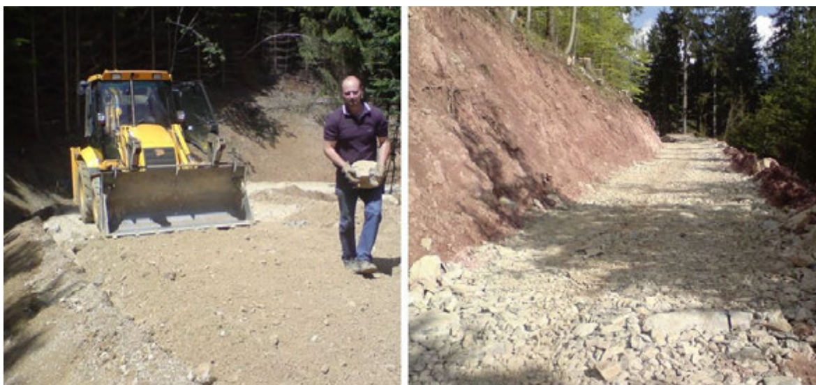
Slika 81: Odstranjevanje neustreznih zrn (levo) in njihova vgradnja v nosilne plasti ceste (desno)
