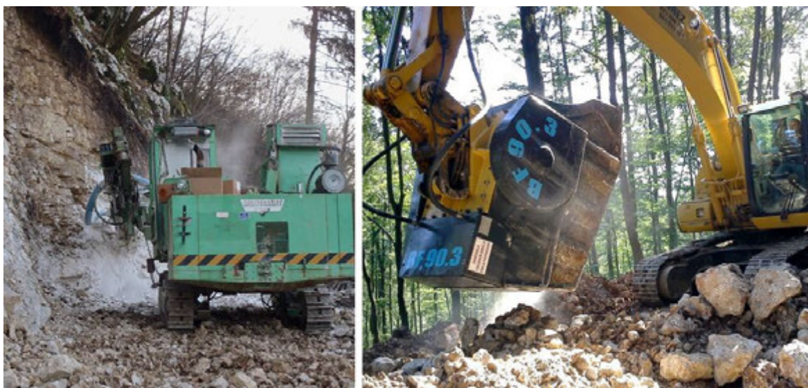
Slika 15: Miniranje pri gradnji na težkih terenih (levo) in »in-situ« drobljenje lokalne kamnine (desno) kot glavna vira materiala nosilnih plasti gozdnih cest v prihodnje
