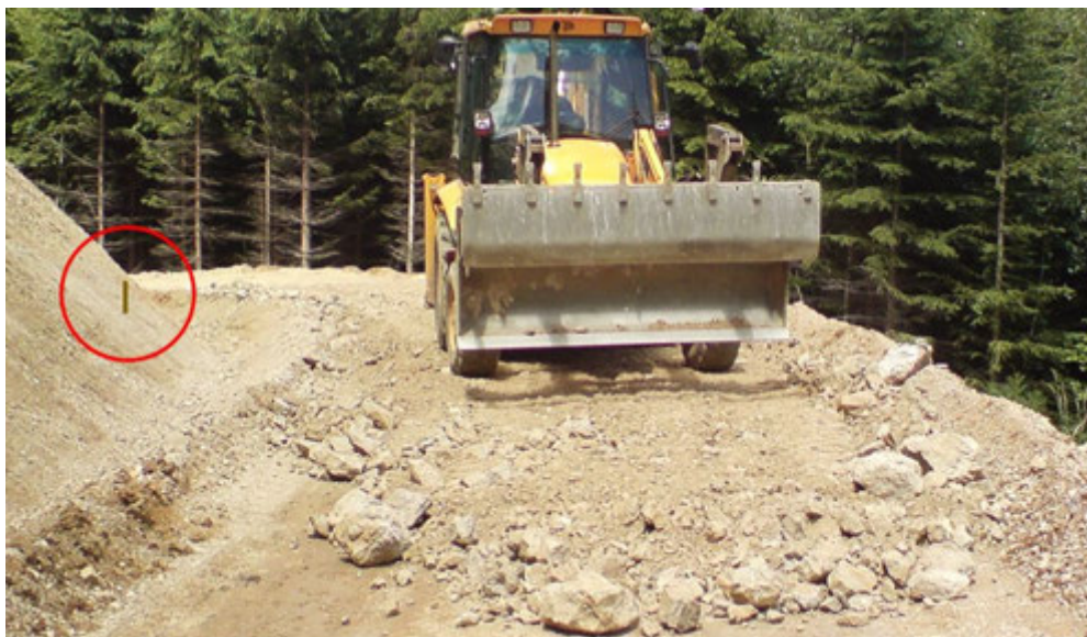
Slika 25: Spremljanje poteka izdelave nosilne plasti na opazovalnem odseku ceste »Bajs« z označeno referenčno točko opazovalnega prečnega profila na odkopni brežini (v krogu)
