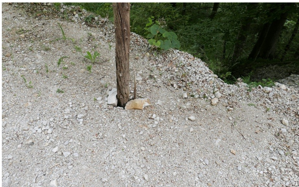
Slika 14: Luknja v vozišču, zaradi varnosti označena s kolom (Foto: Miha Černe)
