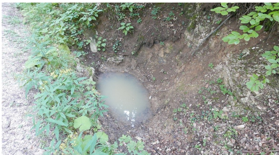
Slika 16: Velika jama namesto vtočnega jaška (Foto: Miha Černe)
