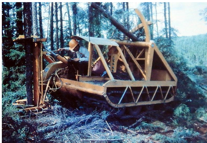
Slika 1: Prototip prvega sečno-spravnega stroja leta 1957, izumitelj: Rudy Vit, Quebec, Kanada (Drushka in Konttinen, 1997)
