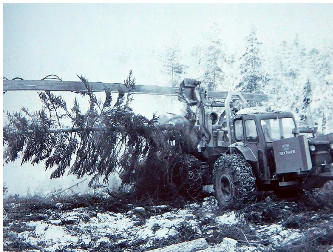
Slika 7: Prvi švedski procesor VSA za kleščenje in krojenje iz leta 1966 (Drushka in Kontinen, 1997)
