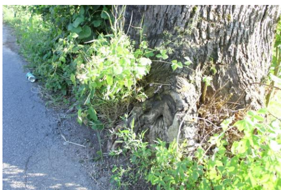
Slika 25: Poškodba korenin in korenin na A.
