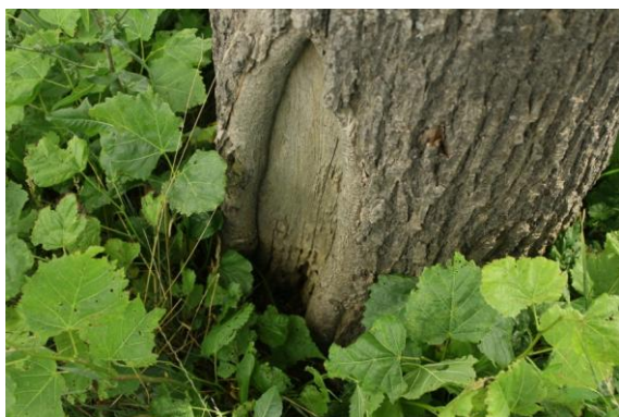
Slika 95: Nepreraščena poškodba pri dnu na A.
