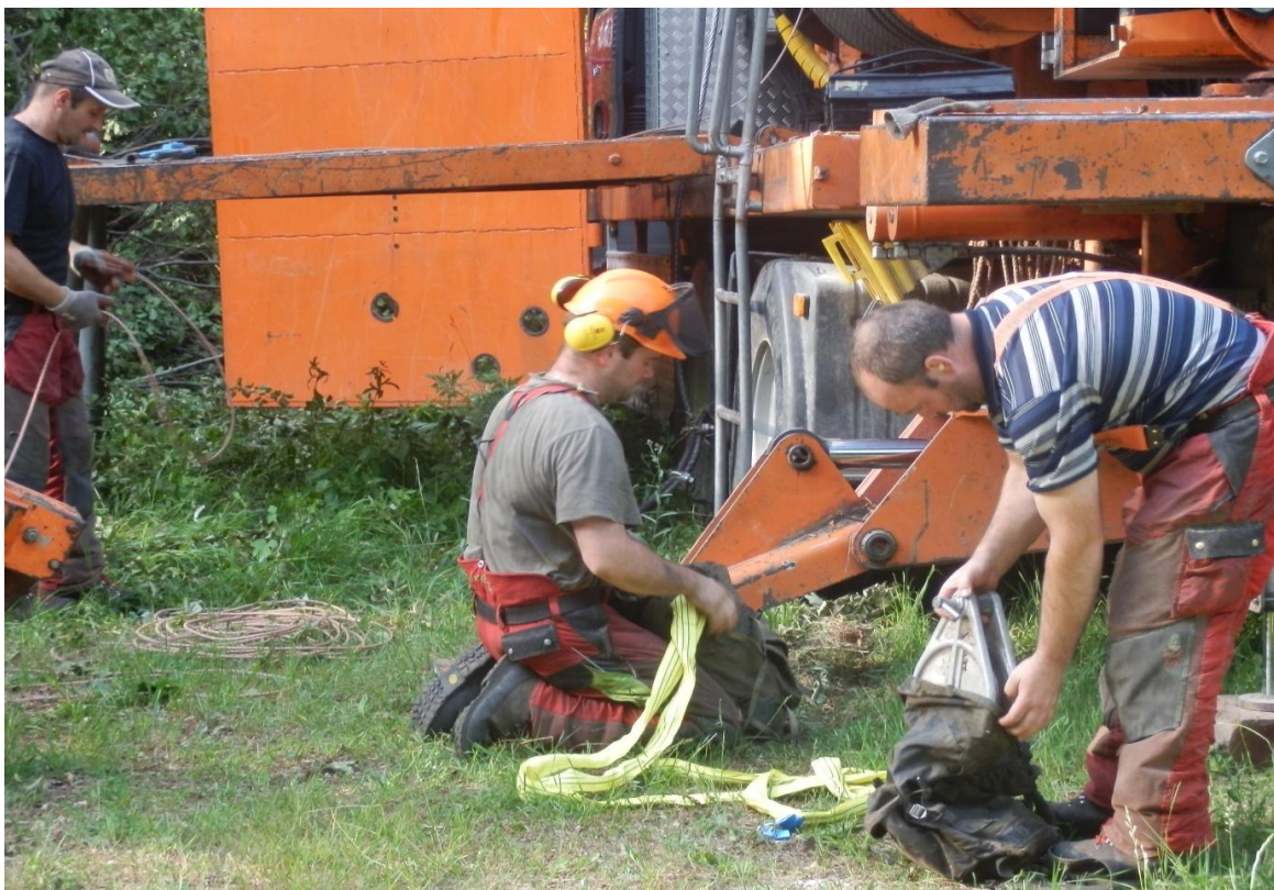
Slika 3: Pripravljalna dela pred razvlačevanjem montažne vrvi
