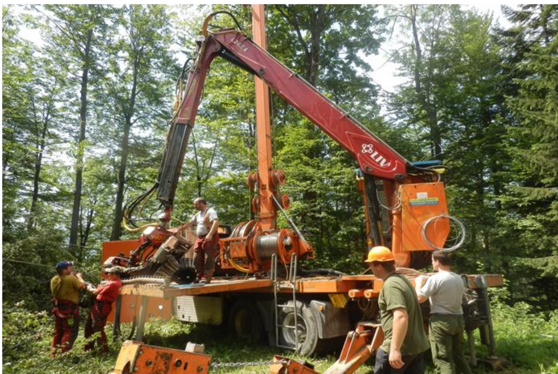
Slika 4: Montaža žičnega žerjava
