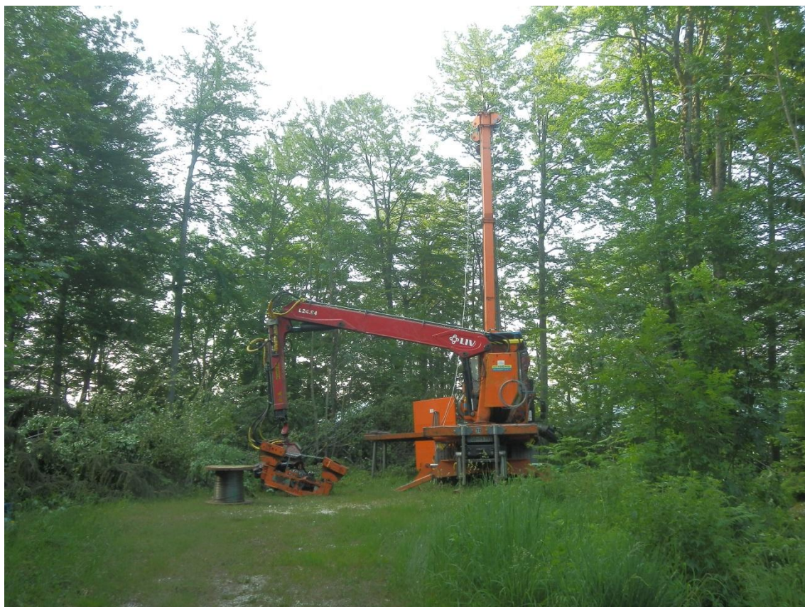
Slika 1: Žični žerjav z dvigalom in procesorjem na stojšču pred montažo
