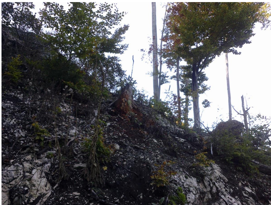
Slika 3: Erozijska površina na sanirani površini (Nemškarica) (foto: Luka Dimnik, julij 2012)
