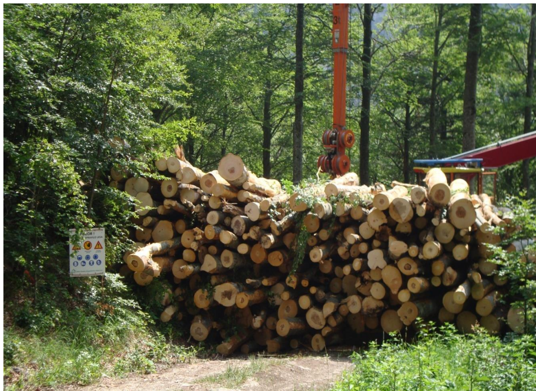
Slika 2: Delovišče oziroma stojišče univerzalnega žičničnega žerjava s stolpom; za kupom gozdnih lesnih sortimentov je kamionska kompozicija, na katero sta vpeta stolp in hidravlično dvigalo
