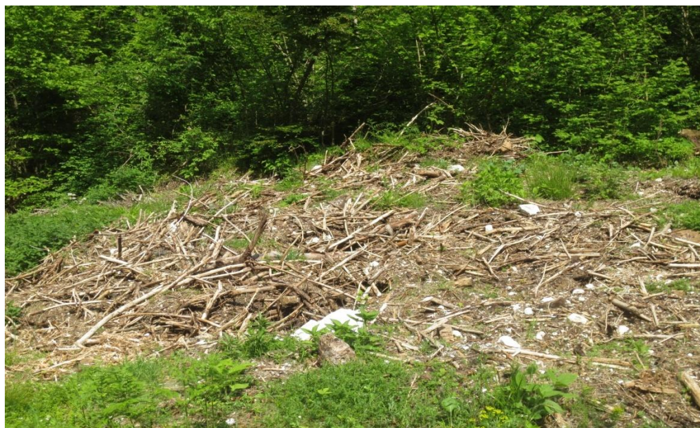
Slika 9: Delovišče v Loški Koritnici, ki se je uredilo z deponiranjem vejevine v jarek; zgornja drobnejša plast predstavlja sekanico, s katero je bila vejevina prekrita
