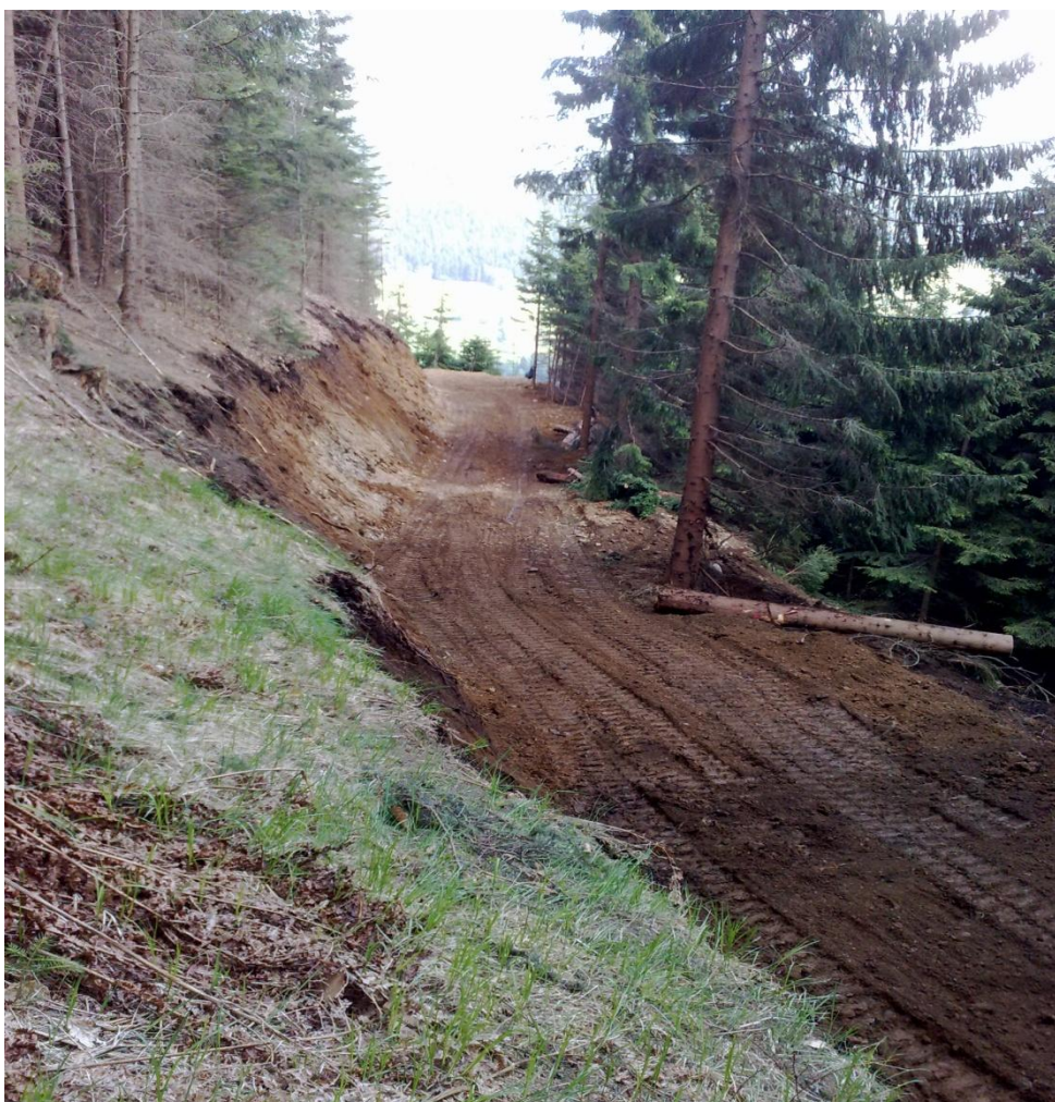
Slika 4: Prečni profil gozdne vlake na terenu (Foto: Dlopst B.)
