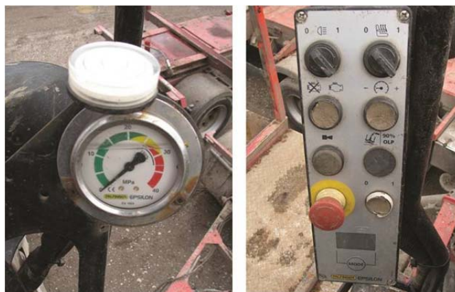
Slika 24: Varnostno dodatna oprema dvigala. (foto: R. Ferle)
