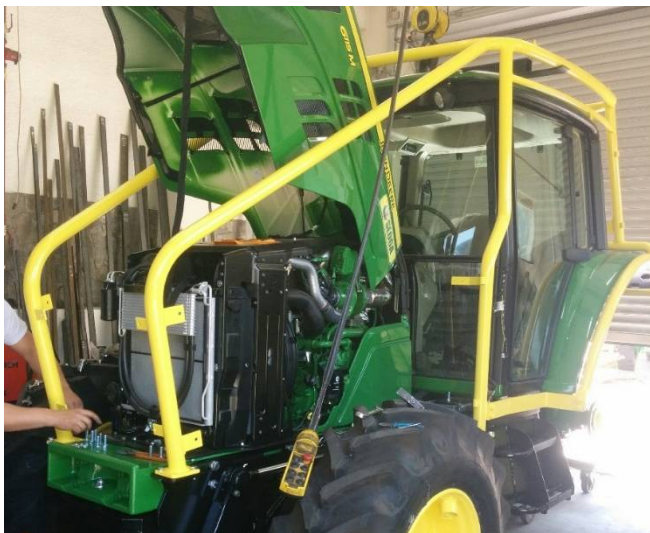
Slika 40: Nameščanje varnostnega loka kabine (Foto: Kotar M.)
