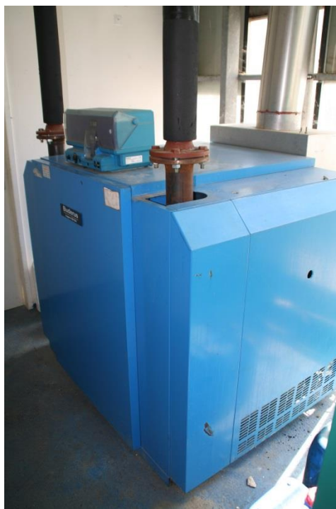
Slika 8: Buderusov kotel za ogrevanje rastlinjaka Fakultete za kmetijstvo in biosistemske vede
