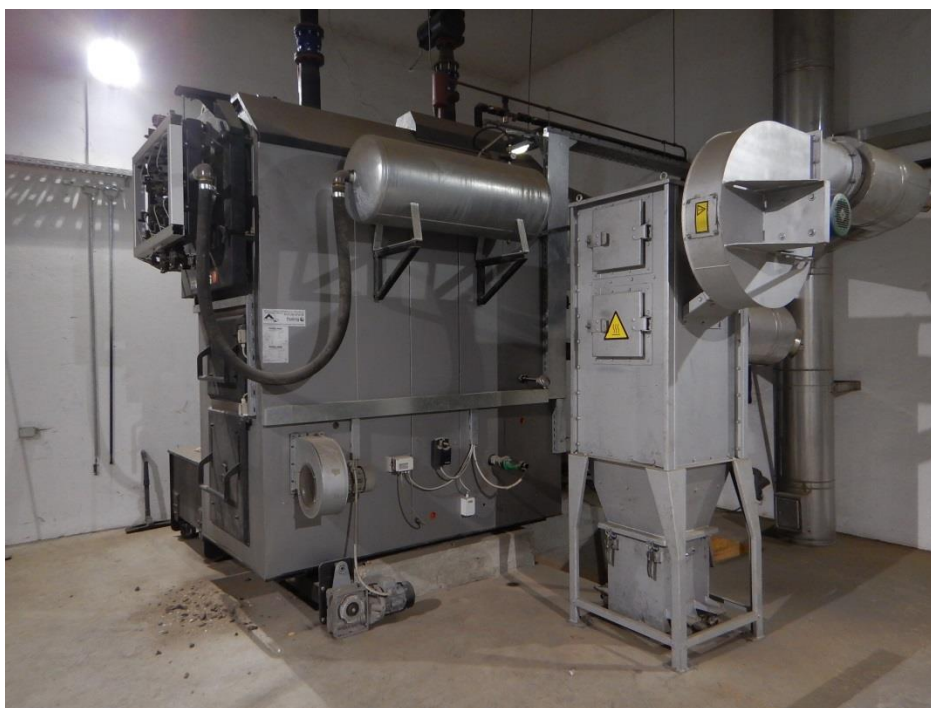
Slika 6: Frölingov kotel Lambdamat 500 za ogrevanje gradu Hompoš
