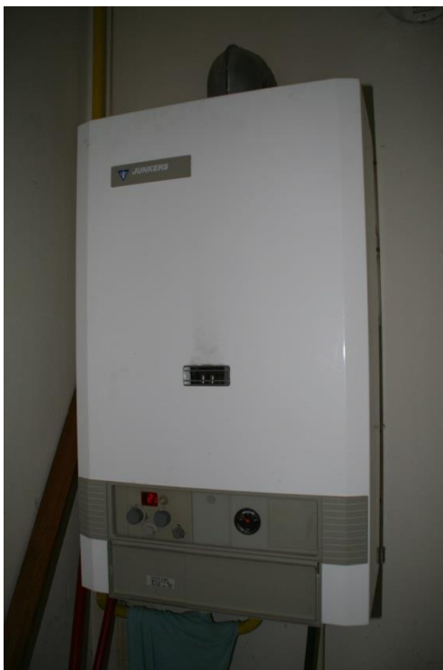
Slika 7: Eden od etažnih kotlov Junkers v objektih Fakultete za kmetijstvo
