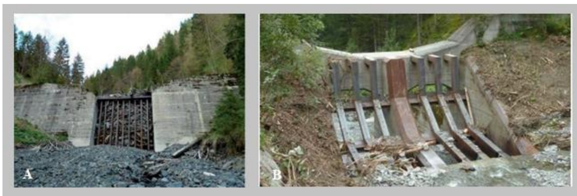
Slika 25: Zadrževalni pregradi za zaustavitev lesenega plavja. Zapolnjena filtrirno-zadrževalna pregrada na hudourniku Suhelj (A) (Sediment Management ..., 2014). Očiščena hudourniška filtrirna pregrada v Avstriji (B) (Sediment Management ..., 2015).
