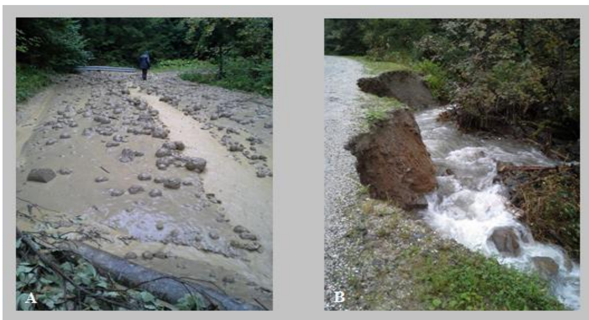
Slika 12: Septembrsko neurje 2014. Posledica zamašitve cevnege prepusta s plavinami in z lesenim plavjem je z naplavinami zasuto cestišče (A). Posledice bočne erozije so zajede oz. odnesene brežine na makadamski cesti (B) (Dimnik, 2016).
