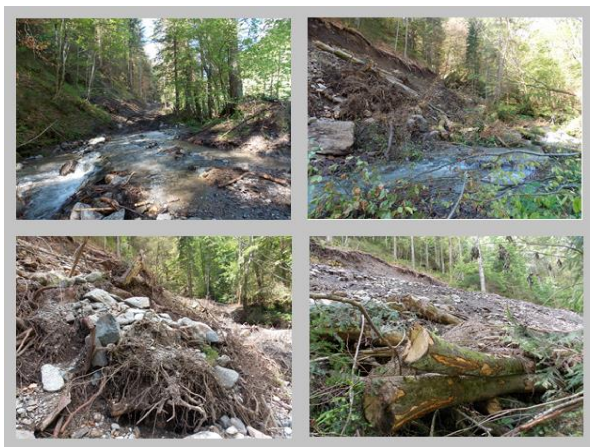
Slika 23: Povsem nova vlaka, ki poteka čez reko Mežo in se nato nadaljuje tik nad njeno strugo, je povečala poplavno in erozijsko ogroženost na tem območju. Odkopni material, s katerim je zasuto večje število izruvanih panjev in gospodarsko nezanimivih lesnih sortimentov, bo ob pojavu visokih voda tok Meže začel odnašati kot plavine, nakar se bodo v tok začeli vključevati tudi zasuti leseni ostanki in bodo kot leseno plavje povečali poplavno ogroženost. Foto: Tadej Lamprecht.
