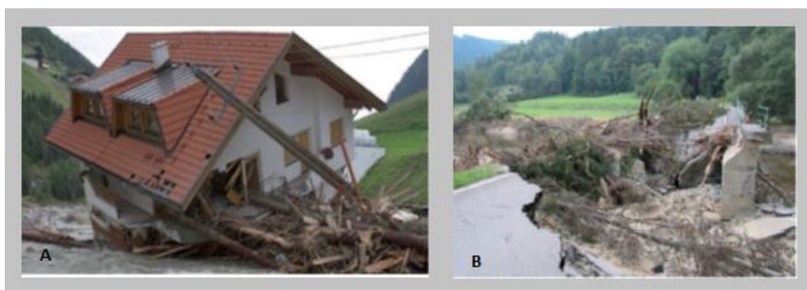
Slika 18: Poškodbe zaradi lesenega plavja na stanovanjskem objektu in električni infrastrukturi (A). Poškodbe na prometni infrastrukturi zaradi zamašitve mostne konstrukcije z lesnim plavjem (B) (Rudolf-Miklau in sod., 2011).
