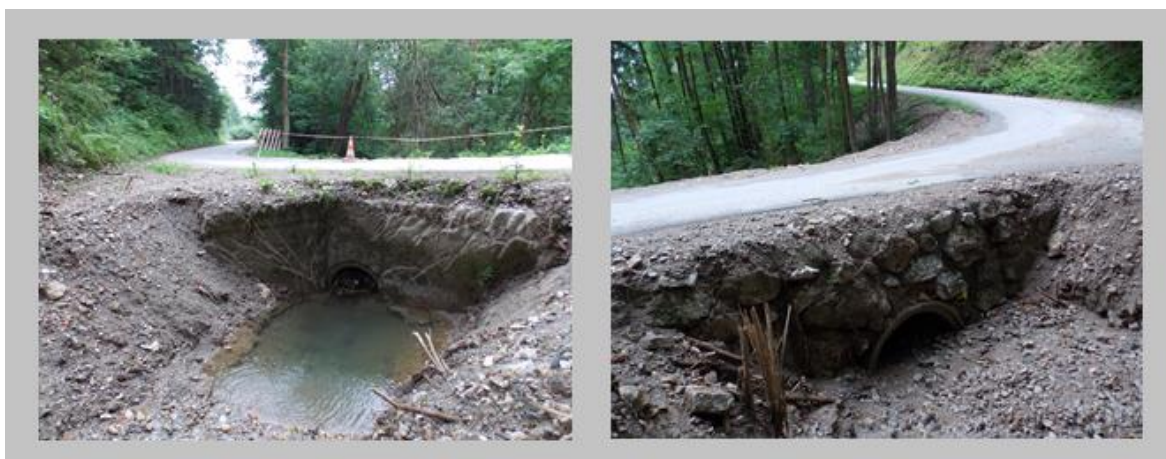
Slika 20: Del naplavin je bil s strani pristojnih izvajalcev v bližini cevnih prepustov iz struge hudourniškega pritoka Meže odstranjen. Cevna prepusta pa sta več kot mesec dni po neurju še vedno zabita s plavinami in z lesenim plavjem. Foto: Tadej Lamprecht.
