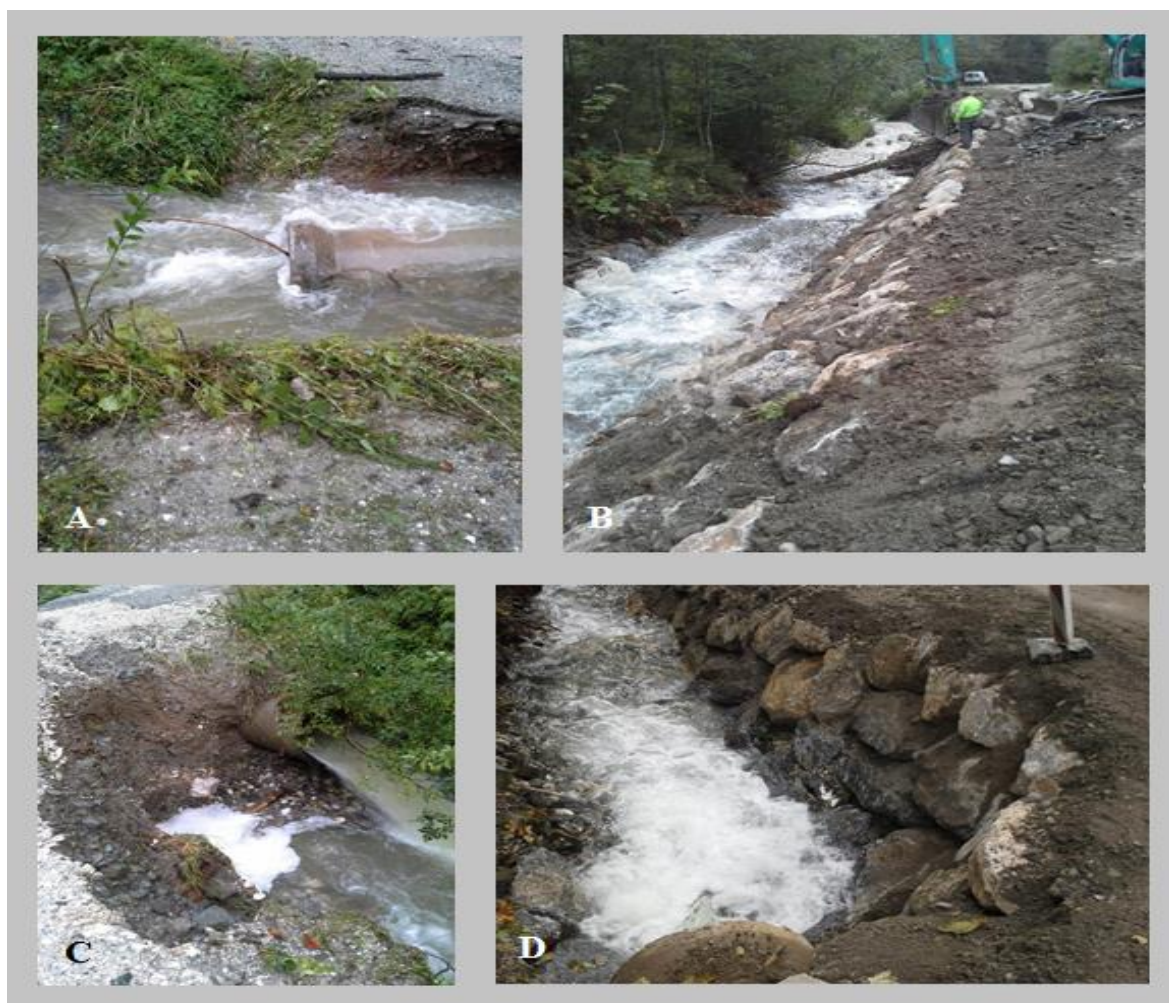
Slika 11: Septembrsko neurje 2014. Poškodbe cestišča, ki so nastale zaradi zamašitve prepustov s plavinami in z lesnim plavjem (A in C). Sanacija po ujmi poškodovane cestne infrastrukture (B in D) (Dimnik, 2016).
