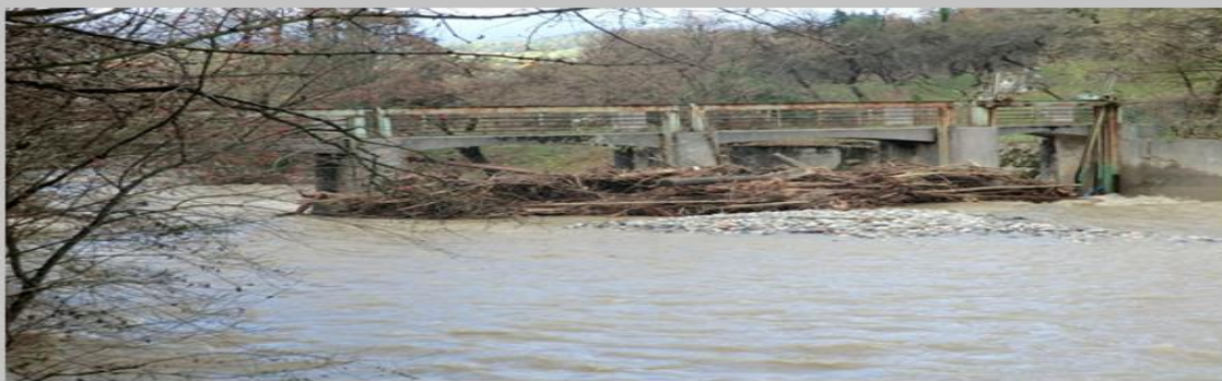
Slika 10: Leseno plavje in plavine, ki jih je tok Meže v novembrskih poplavah 2012 transportiral iz svojega zaledja in z njimi zamašil del mostne konstrukcije v Mežici (Trdina, 2016; foto: Nenad Donau).
