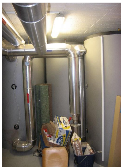
Slika 21: Hranilnik toplote prostornine 5,4 m 3 (foto: A. Sodja)
