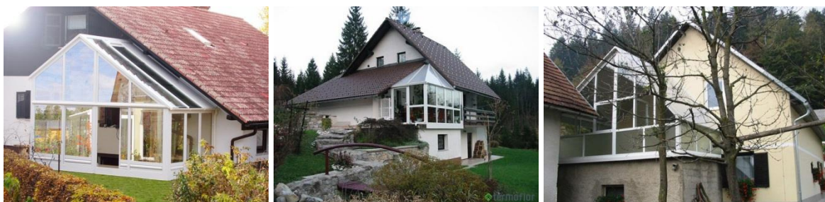
Slika 16: Zimski vrtovi, ki so bili dograjeni k tradicionalnem objektu (levo: Zimski vrtovi. AJM ..., 2013, sredina in desno: Zimski vrtovi. Termoflor ..., 2013)
