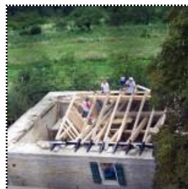
Slika 37: Prenova strehe glavnega objekta (Parkistra.com, 2016)
