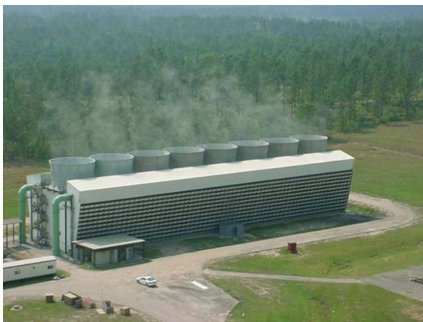
Slika 4: Hladilni stolp na prisilni vlek (Thermwood CNC, 2015)
