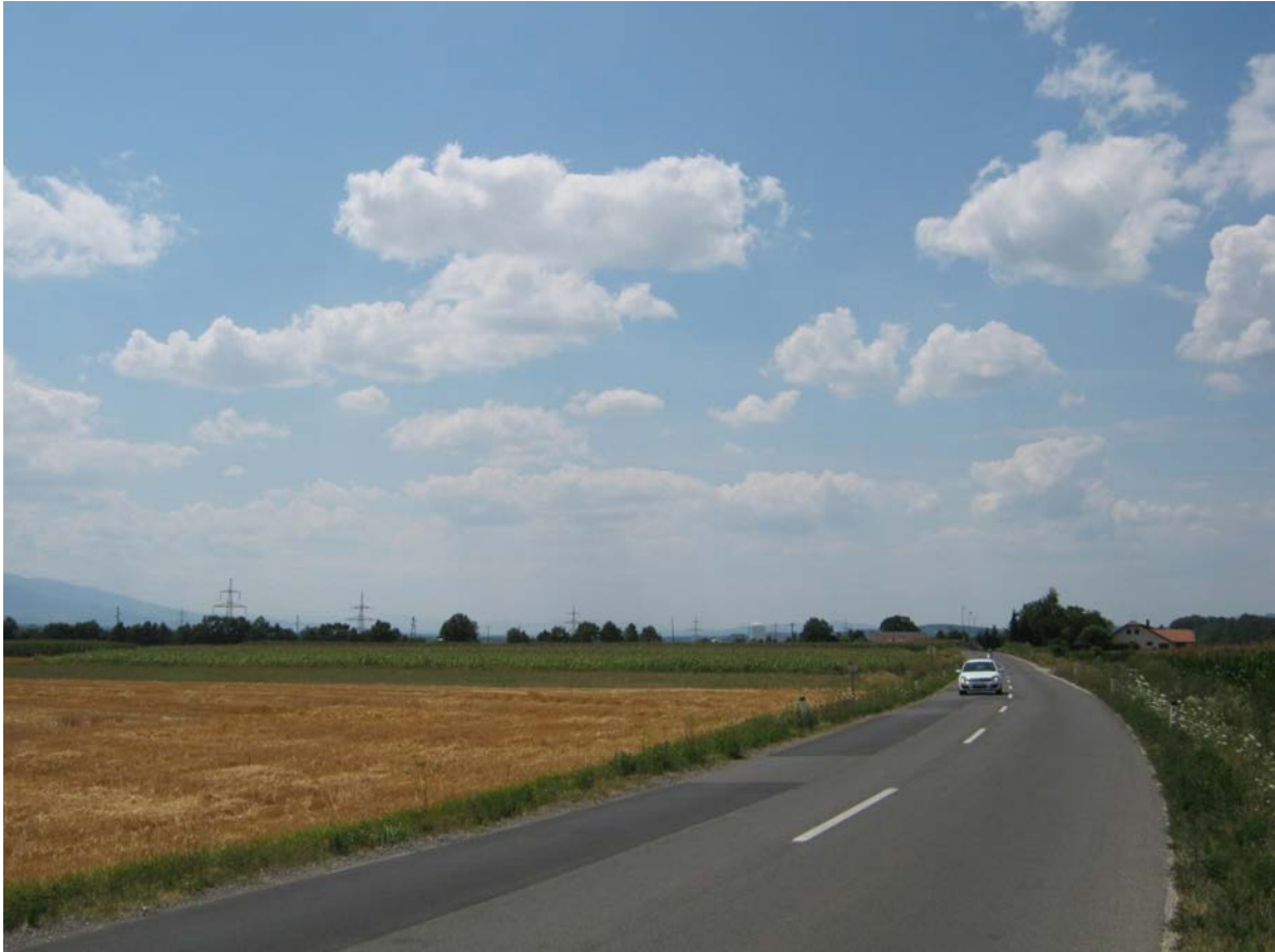
Slika 41: Pogled s ceste Brežice - Pohanca - Krško, odsek pri Dolenji vasi
