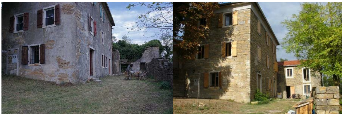
Slika 16: Center TPI ob začetku obnove leta 2014 in po dveh letih (Trajnostni ..., 2016)
