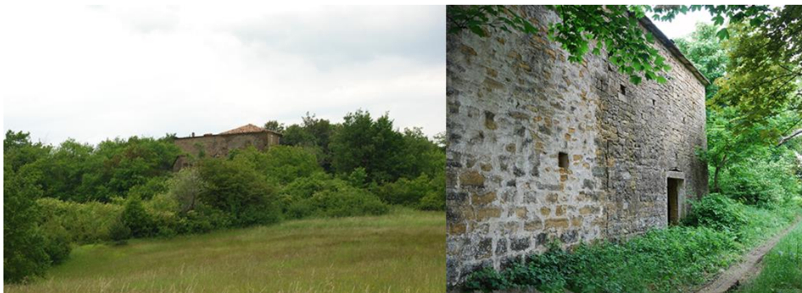
Slika 31: Pogled na zaselek Močunigi z jugovzhoda in gola severna fasada domačije.
