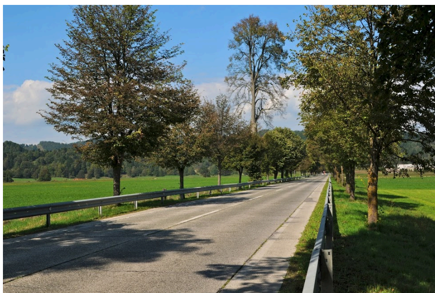
Slika 1: Betonsko cestišče skozi drevored in varnostna ograja (Foto: Sušnik, 2013)
