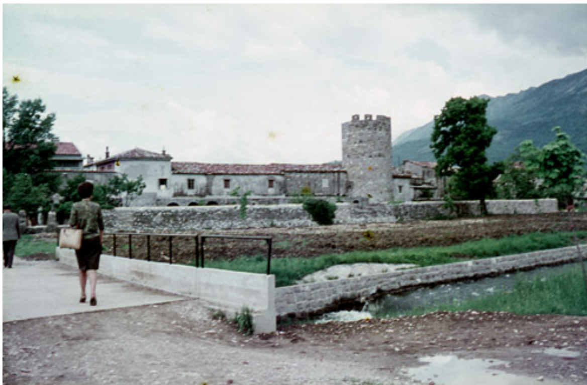
Slika 55: Fotografija prikazuje nov most čez reko Hubelj, v ozadju je vidna že zgrajena veleblagovnica Nanos leta 1969 (Občina Ajdovščina, 2011)
