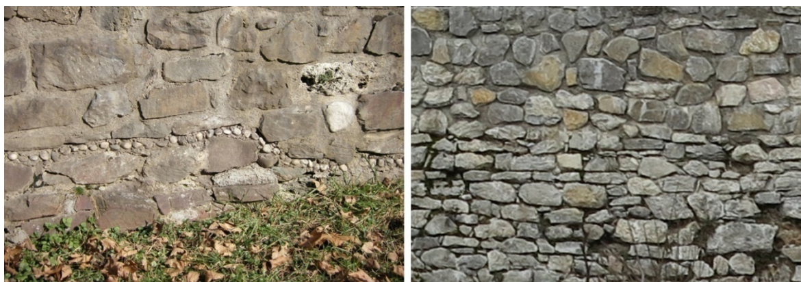
Slika 44: Levo: primer dozidave- zunanje lice južne stranice emonskega obzidja na Mirju. Svetli prodniki predstavljajo ločnico med ohranjenim in restavriranim delom zida. Desno: dozidava na Starem gradu; način gradnje je popolnoma drugačen kot nekoč. Ločnica med starim in novim ni potrebna.
