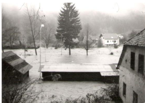
Slika 35: Poplava je poškodovala objekte na območju (Pintar, 2011)
